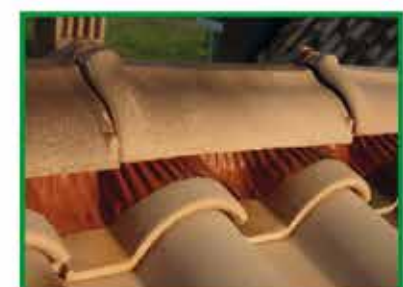
POSA DELLE TEGOLE E CHIUSURA COLMO
