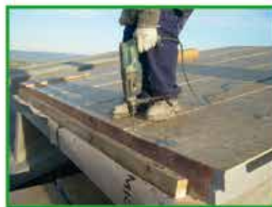
FISSAGGIO PANNELLI
