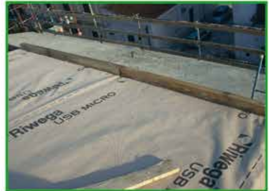
STESURA FRENO VAPORE
