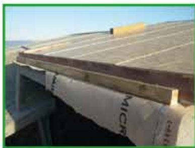
FISSAGGIO LISTELLO DI PARTENZA
