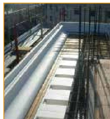
Le casseforme in EPS prima del getto devono essere trattate con il **DISTACCANTE** al fine di agevolare la fase di disarmo, inoltre possono essere rivestite con film in PVC.
